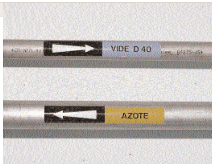
Les couleurs apposées sur la tuyauterie délivrent un message de sécurité
