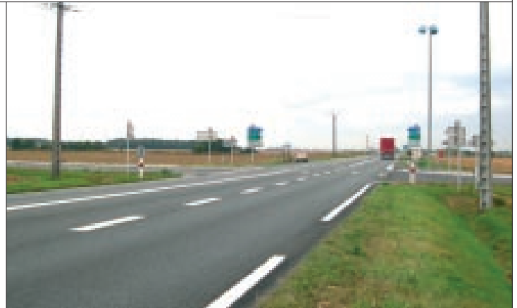
Itinéraire pilote sur la RN 151, entre Châteauroux et la limite de l'Indre et du Cher.
